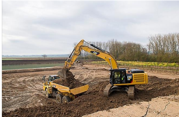
Remplissage des dumpers par pelleteuse
